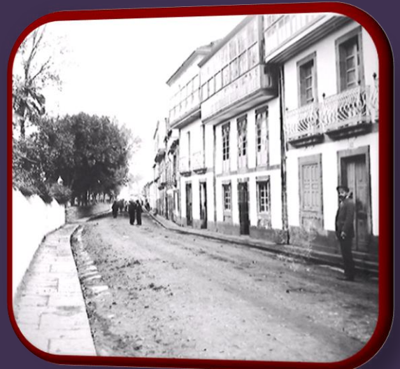
Todo el cierre y arbolado, que se ve a la izqda. que va desde el casino hasta la Caixa Galicia incluida ,era terreno del Balneario, y de fondo hasta la calle Perú
